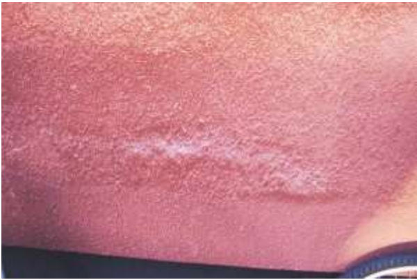
Bild 2- 3. Putzschäden. Der Putz hat sich von der Wand gelöst und wird nur durch die äußere Schicht des Spritzputzes verbunden. Die Oberfläche wölbt sich ein wenig aus und wenn jemand mit einer Messerspitze auf die Oberfläche testet, geht es durch. Die Bühne vor diesem ist, dass es klingt gedämpft, wenn Klopfen auf sie mit dem Messer, aber die Spitze geht nicht durch. Wenn es mit perfekt gesundem Pflaster kollidiert, ist der Klang jedoch viel weniger gedämpft.
