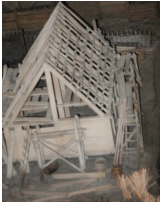
Ett hus under uppförande i Birka.
