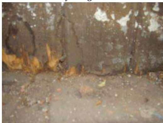
Bild 4. Fuktskadat trä.
