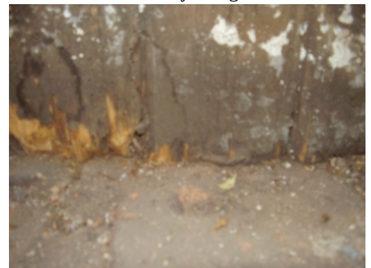
Bild 4. Fuktskadat trä.
